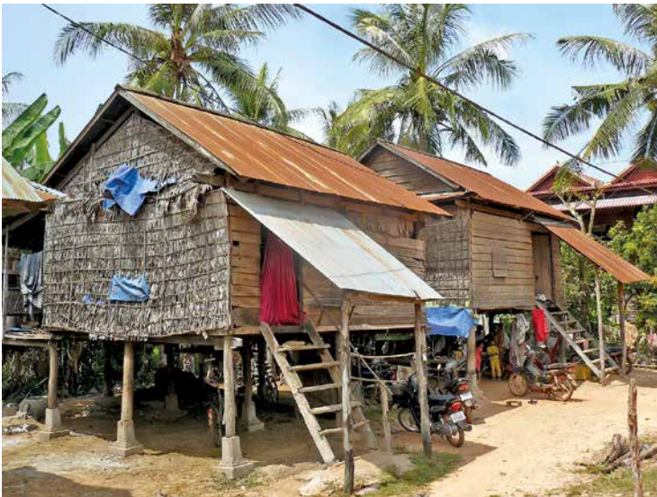
Abb. III: Einfache Wohnhäuser in Zentral-Kambodscha (Kratie-Provinz). Die fehlenden festen Wände sind heute ein Indikator für extreme Armut, wohingegen das fast überall verbreitete Wellblechdach selbst bei sehr armen Haushalten zur Regel geworden ist.
